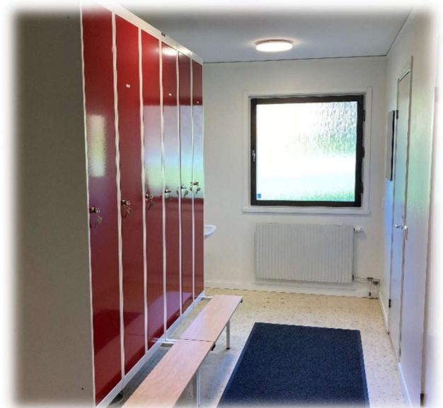
Renovering av damomklädningsrum på Änge brandstation
