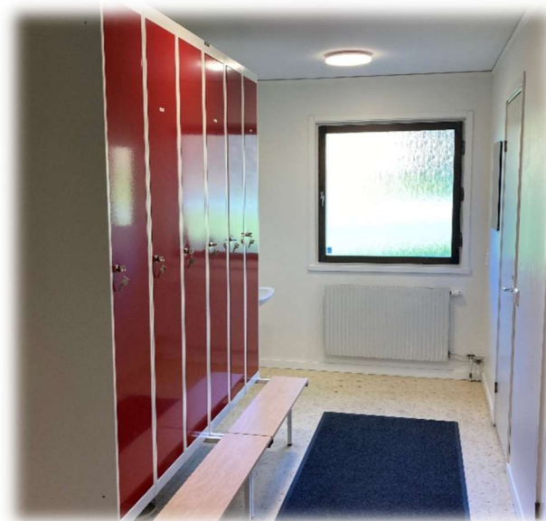
Renovering av damomklädningsrum på Änge brandstation
