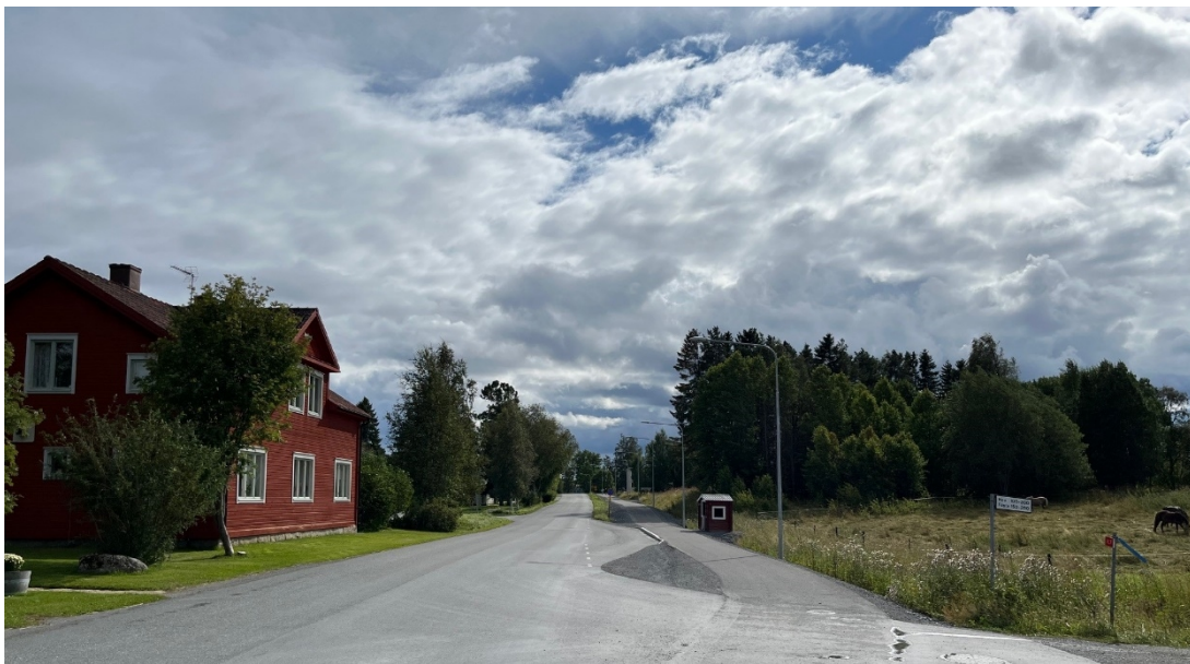
Figur 5 Gång- och cykelväg genom Hackås, Bergs kommun.
